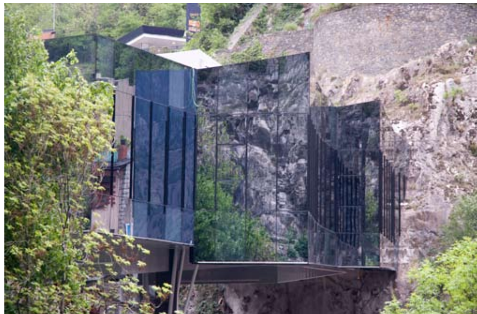
El recolzament del Roc del Metge, on la penya entra a l’interior de l’edifici.
